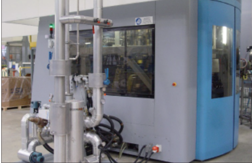
Bild 2: Produktionsanlage für PET-Flaschen (im Vordergrund die 28-bar-Druckluftleitungen).
